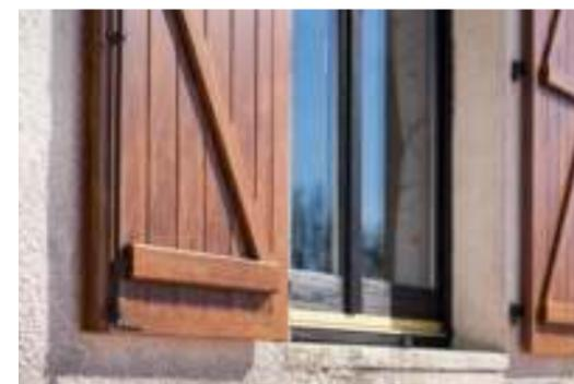
Nos volets isolants sont constitués de 2 tôles de 15/10<sup>e</sup> avec isolant **thermique** et **phonique** de 20 ou 30 mm d'épaisseur (XPS), soit une épaisseur totale de 37 mm.
